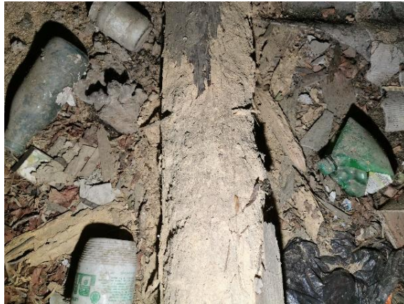
16 pav. Mediena pažeista entomologinių kenkėjų
