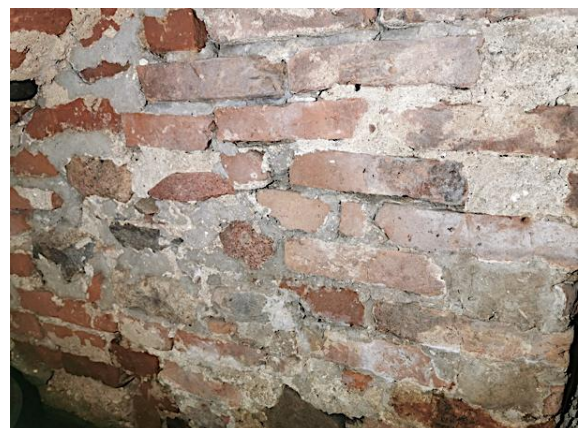
11 pav. Rūsio patalpų mūrinių sienų pažaidos
