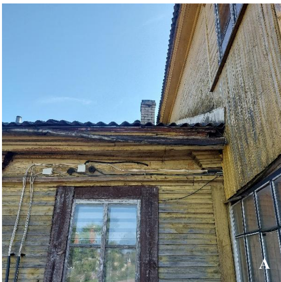
4 pav. Mediena praradusi mechaninį tvirtumą, matomos patamsėjusios dėmės: A – vakarų fasado kairėje; B – rytų fasado kairėje
