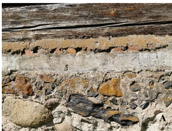
3 pav. Ant rytų (A) ir šiaurės (B) fasadų pamato vegetuoja kerpės
