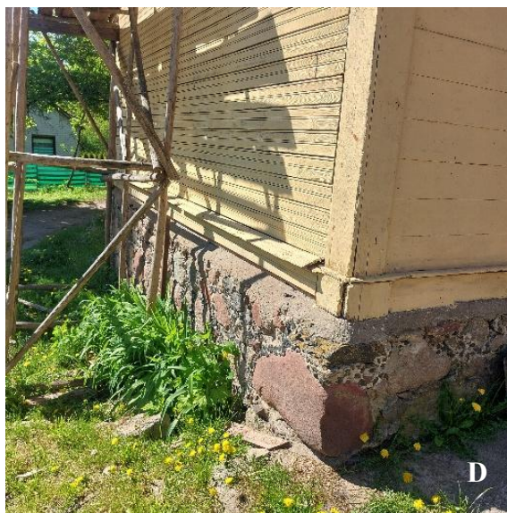
1 pav. Aplink pastatą neįrengta arba netvarkinga nuogrinda: A ir B – pietų fasade per arti pastato auga aukštesnieji augalai: žolės, krūmai ir jauni medeliai; C – prie šiaurės fasado neįrengta nuogrinda; D – prie rytų fasado nuogrinda apaugusi aukštesniaisiais augalais
