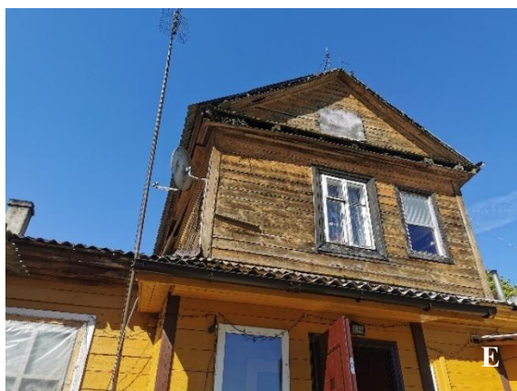
7 pav. Beveik visu pastato perimetru neįrengta arba netvarkinga vandens surinkimo ir nubėgimo sistema: A ir B – vakarų fasadas; C – pietų fasadas; D – šiaurės fasadas; E – rytų fasadas 3-1 patalpa; F – rytų fasadas 2-1 patalpa
