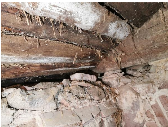
10 pav. Mediena paveikta drėgmės
