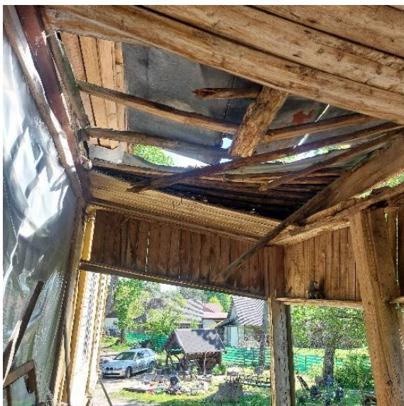
5 pav. Įlūžusios pietų fasado verandos medinės konstrukcijos
