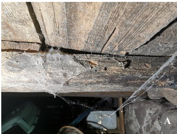
9 pav. Rūsio patalpose mediena pažeista entomologinių kenkėjų: A ir B
