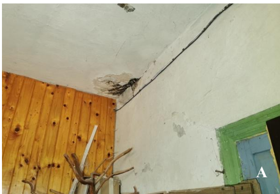
18 pav. Tinko ir dažų pažaidos patalpoje Nr. 0-2: A ir B
