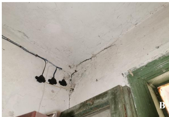
18 pav. Tinko ir dažų pažaidos patalpoje Nr. 0-2: A ir B
