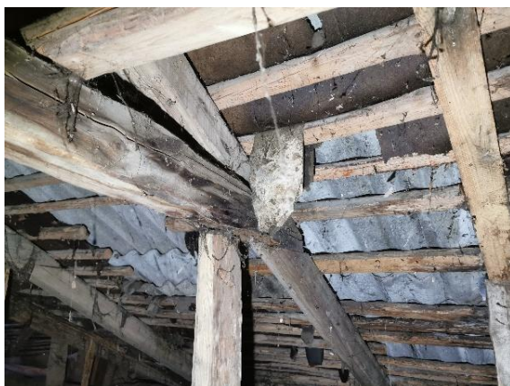
14 pav. Drėgmės paveiktos medinės konstrukcijos
