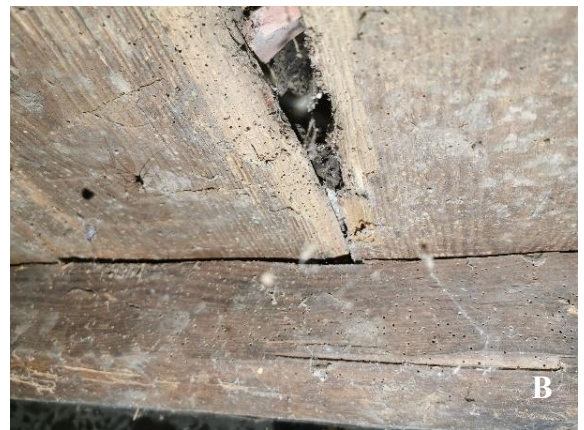
9 pav. Rūsio patalpose mediena pažeista entomologinių kenkėjų: A ir B
