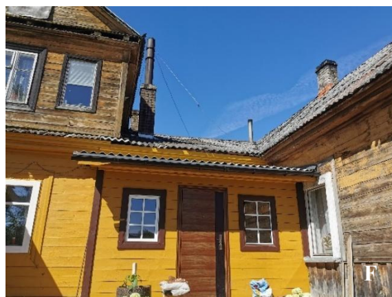
7 pav. Beveik visu pastato perimetru neįrengta arba netvarkinga vandens surinkimo ir nubėgimo sistema: A ir B – vakarų fasadas; C – pietų fasadas; D – šiaurės fasadas; E – rytų fasadas 3-1 patalpa; F – rytų fasadas 2-1 patalpa
