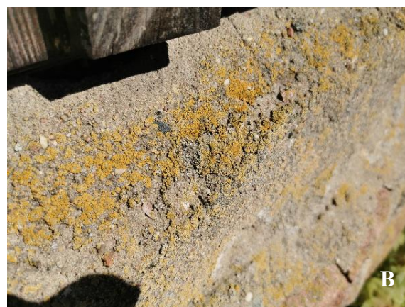
3 pav. Ant rytų (A) ir šiaurės (B) fasadų pamato vegetuoja kerpės
